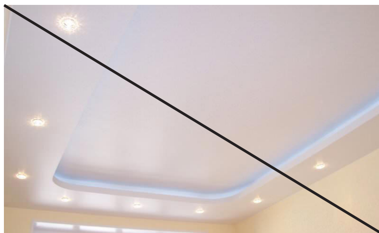
Плохо Многоуровневые гипсокартонные конструкции
